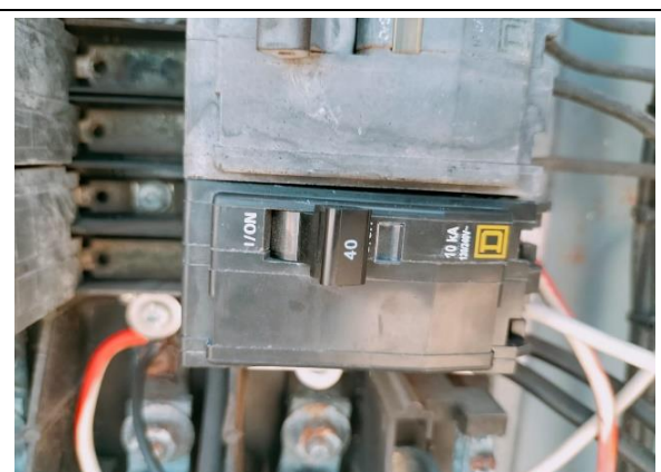
3.2.- Se le dio mantenimiento a la pastilla termo magnético del centro de carga de la unidad deportiva Jaime Tubo Gómez.
