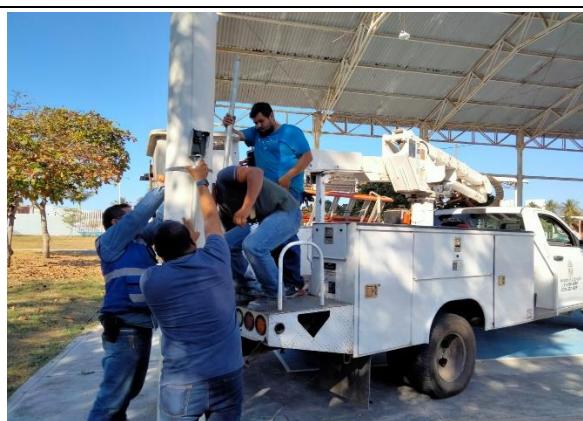
6.9.- Con apoyo de alumbrado público se colocó un centro de carga con tubería reforzada para las lámparas led, en la cancha de básquetbol de la unidad 5 de mayo
