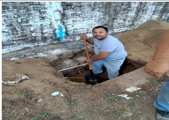
6.3.- Se continuó con los pozos para poner los postes a un lado del parkour, en la unidad 5 de Mayo.
