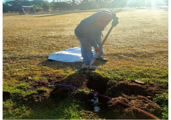
6.14.-Se reparó una fuga de agua adentro del campo de fútbol Héctor Hernández de la 5 de mayo
