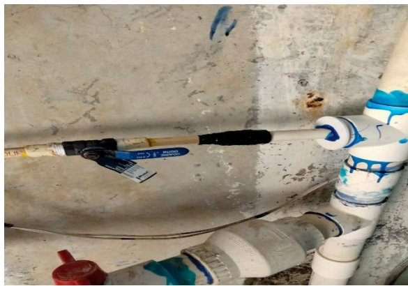
6.20.- Se cambió un aspersor, en el campo de fútbol Héctor Hernández donde estaba la fuga, ya que no funcionaba.
