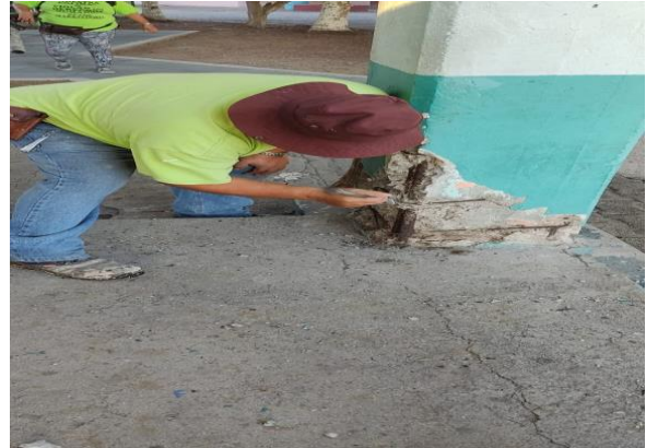
6.15.- Se reparó un castillo que estaba en mal estado en la unidad 5 de mayo
