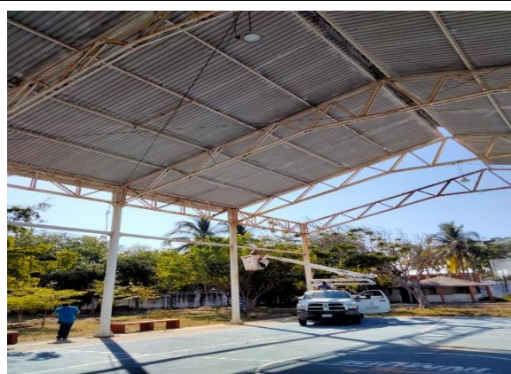
6.9.- Con apoyo de alumbrado público se colocó un centro de carga con tubería reforzada para las lámparas led, en la cancha de básquetbol de la unidad 5 de mayo
