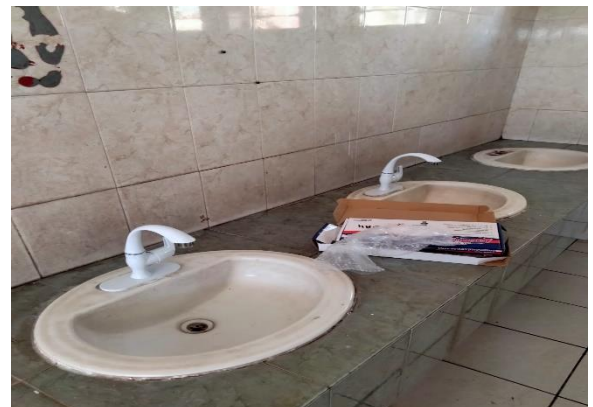
6.17.- Se cambiaron las llaves de los baños en la unidad 5 de mayo que se encuentran abajo de las gradas.
