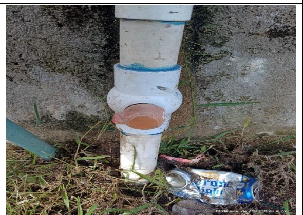
2.1 – Se reparó una fuga de agua de la bomba de riego de la unidad deportiva 5 de mayo.
