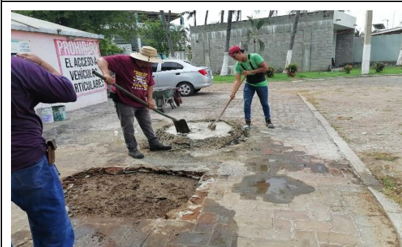
6.2.- Se quitaron unas jardineras y se taparon los huecos con cemento por la entrada principal de la unidad 5 de mayo.
