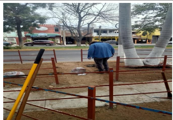
3.3 - Se soldaron varias partes de las jardineras que estaban desoldadas de la entrada principal de la Unidad Tubo Gómez.
