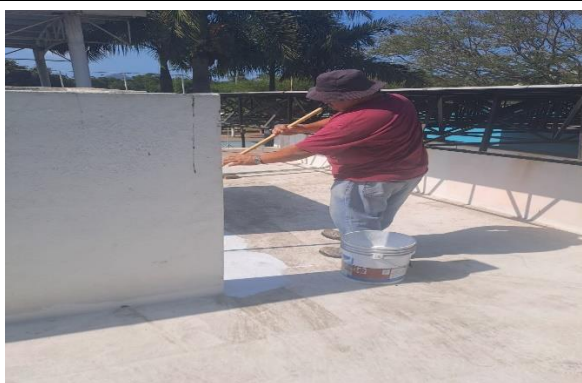
5.6.- Se impermeabilizaron los baños de la tubo Gómez
