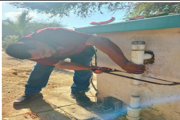
3.5.- Se cambió una llave de 2 pulgadas en el Garcero ya que estaba en mal estado.
