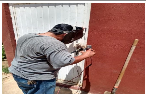
3.7.- Se cambiaron las chapas de los baños del Garcero y se soldaron.
