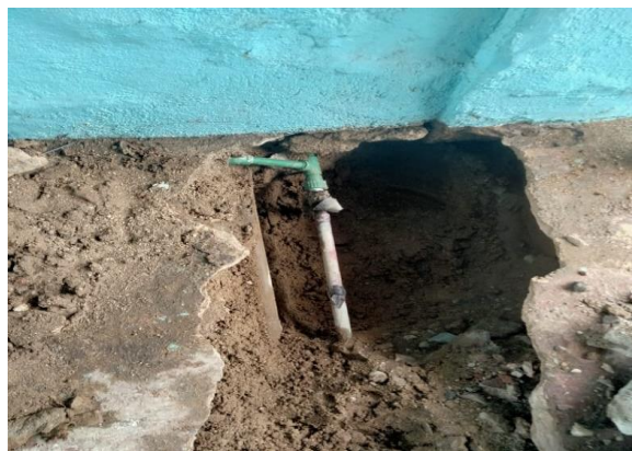
3.11.- Se apoyó con el material para la reparación de la fuga de agua en el López Mateo
