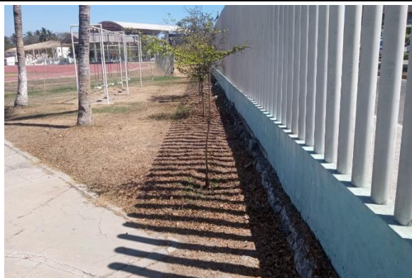
3.2.- Se limpió por dentro toda la entrada principal de la unidad 5 de mayo.
