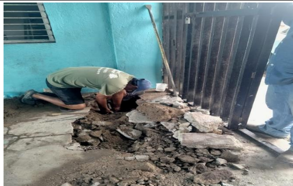
3.11.- Se apoyó con el material para la reparación de la fuga de agua en el López Mateo
