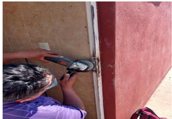
3.7.- Se cambiaron las chapas de los baños del Garcero y se soldaron.
